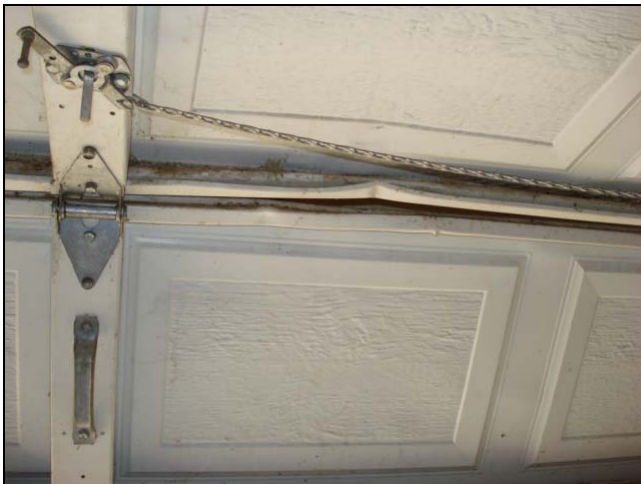
A bent garage door panel.
